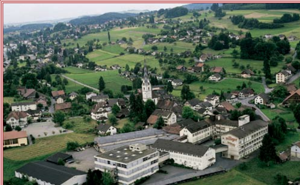
Die Fabrikations- und Lagergebäude von ›Villiger‹ im luzernischen Pfeffikon
